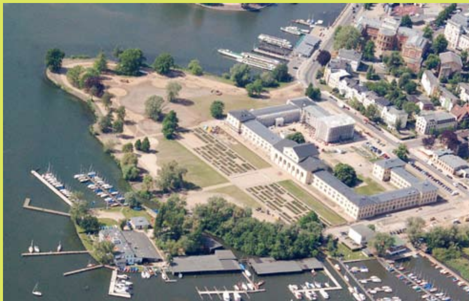
Im Garten am Marstall sind schon deutlich die Formen der Themengärten zu erkennen Foto: BUGA
