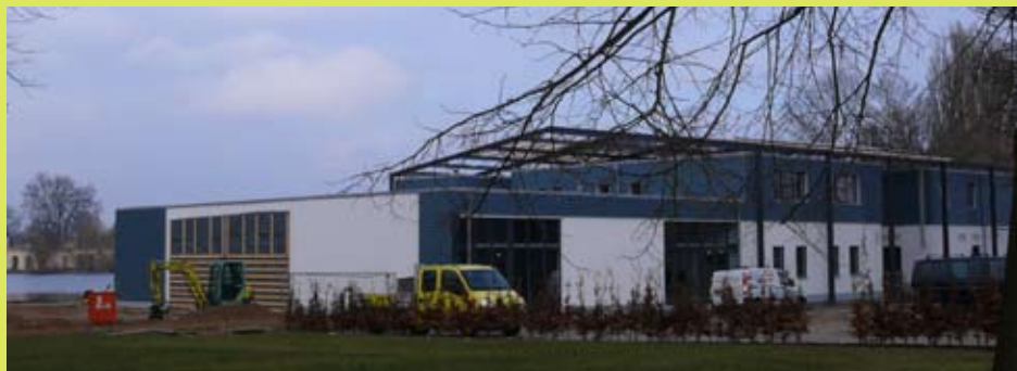
Die Hauptgastronomie im Ufergarten der Bundesgartenschau - derzeit noch im Bau
